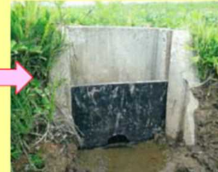
水戸板設置状況
