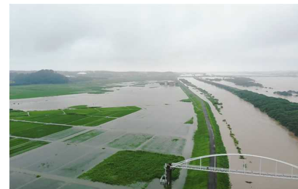
《最上川5.0k付近の浸水被害状況》
