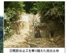
③既設谷止工を乗り越えた流出土砂
