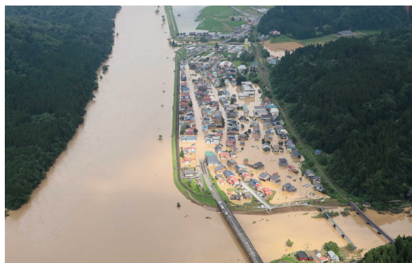
《最上川40.0k付近の浸水被害状況》
