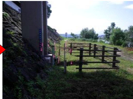
仮設ロープを設置
