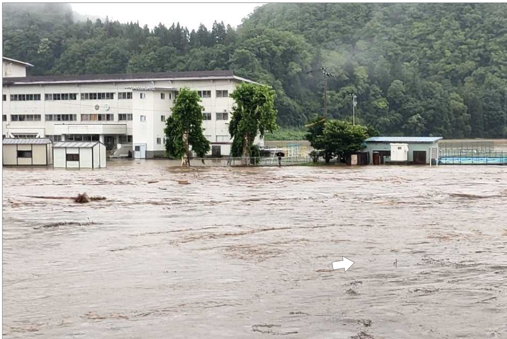
鮭川（真室川町大沢）溢水による浸水
