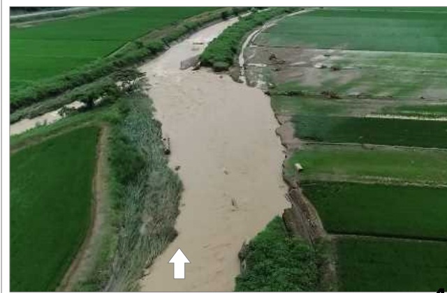
堤防決壊 - 野尻川（尾花沢市寺内）
