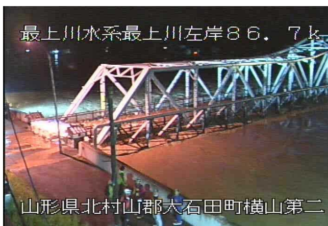
R2.7洪水でのCCTVカメラ画像 (大石田大橋)
