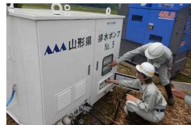
ポンプ操作状況
