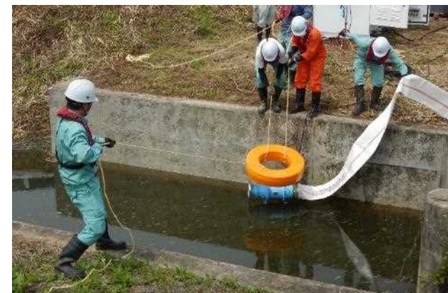
ポンプ・ホース設置状況
