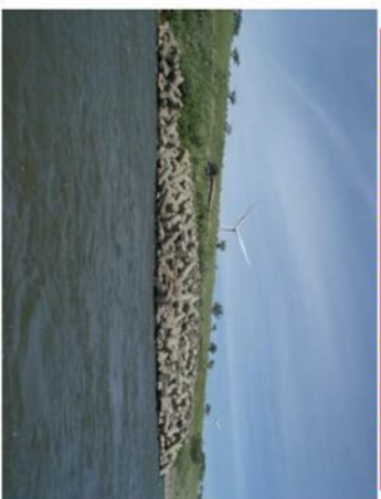
船上から見た河川管理施設(水制工)
