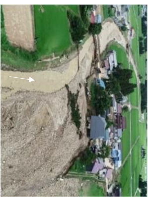
萩生川被災状況(令和4年8月)
