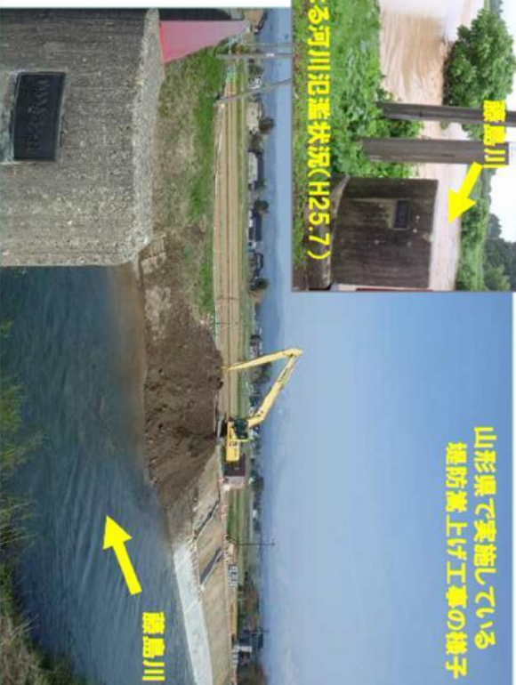
過年度に発生した河川冠濫箇所の 堤防嵩上げ工事を視察
