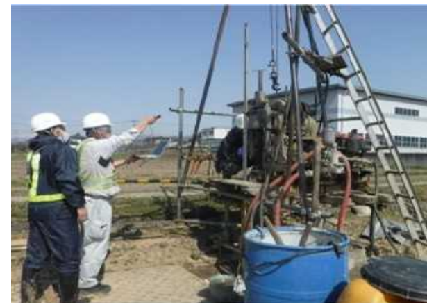
溝延地区地質調査状況
