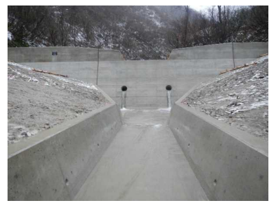
【治山：溪間工（治山ダム）】
