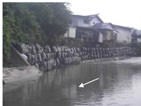
応急工事後(R2.8.6)
