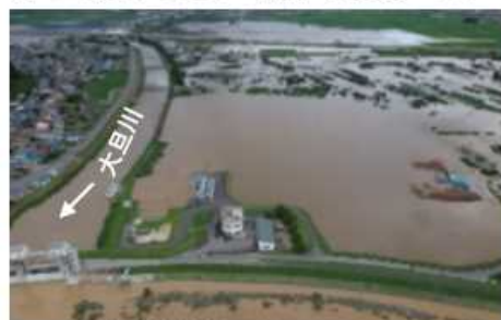
被災状況(R2.7月)
