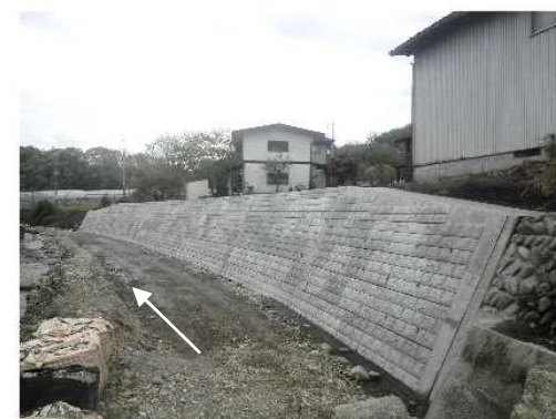
工事完了(R3.5.1)
