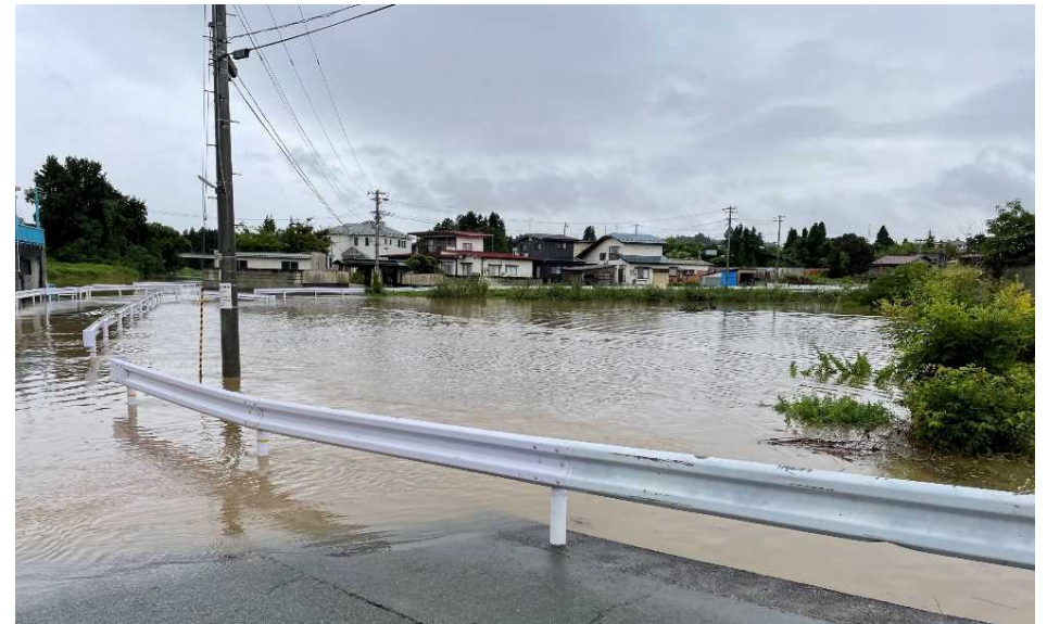
大江町左沢地区における内水被害
