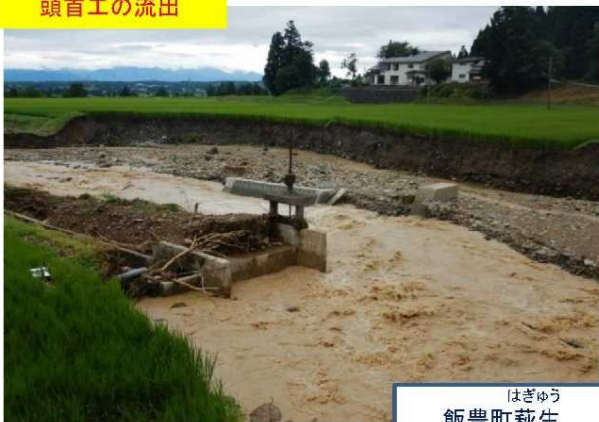
山腹崩落による用水路の閉塞
