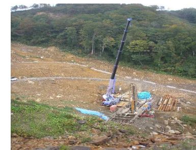
【治山：地すべり防止工】
