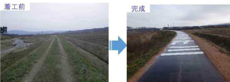
堤防強靱化実施状況(升形川[新庄市])
