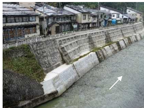
工事完了(R3.9.1)
