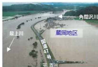
↑被災状況(H30.8月)
