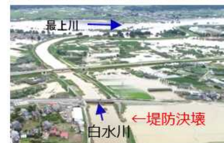
被災状況(R2.7月)
