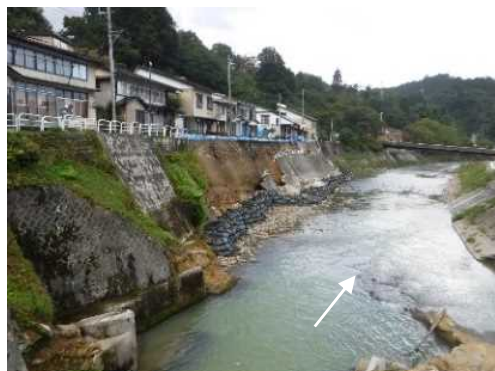
応急工事後(R2.10.6)
