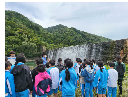
六湊砂防堰堤
