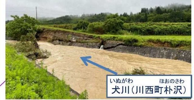
護岸損壊(150m)
