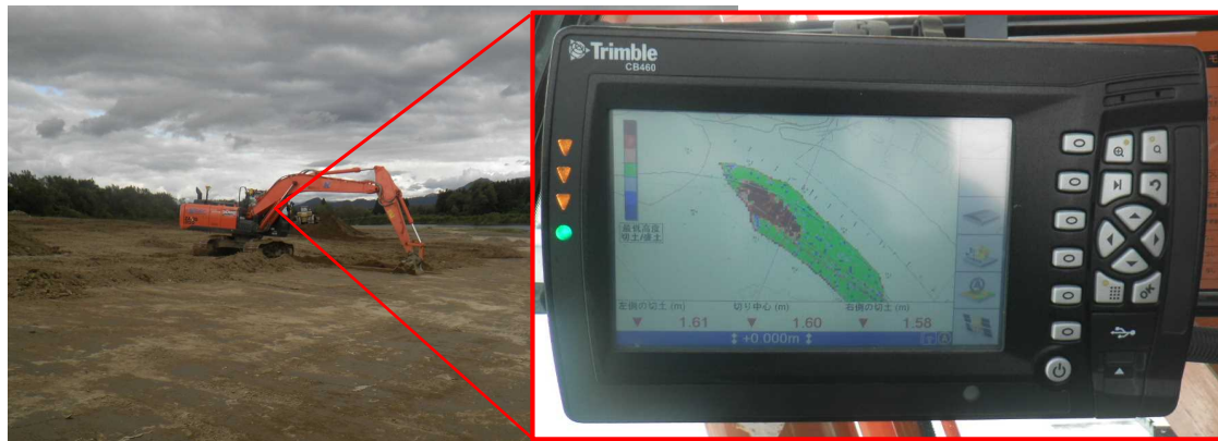
河道掘削工事においてICT建設機械を使用
