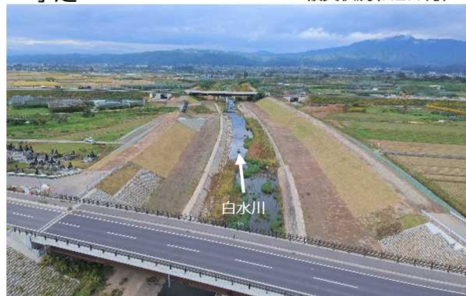
施工状況(R3.10月)
