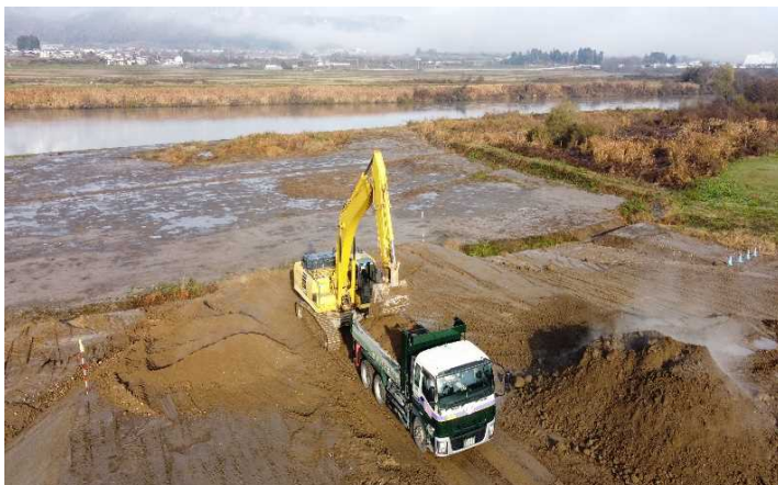
河道掘削工事において掘削した土砂を長島地区の築堤工事の盛土材として活用
