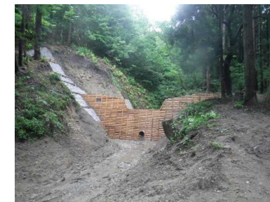
【治山：溪間工 (治山ダム)】
