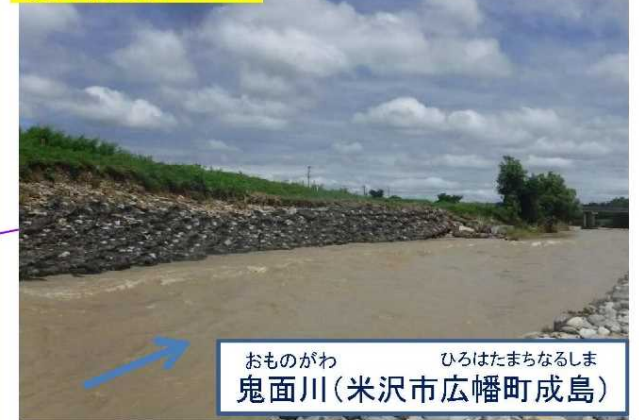
護岸損壊(150m)
