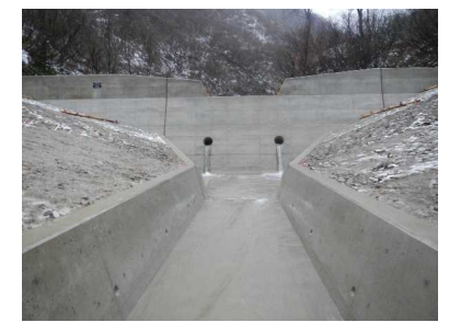
【治山：溪間工(治山ダム)】
