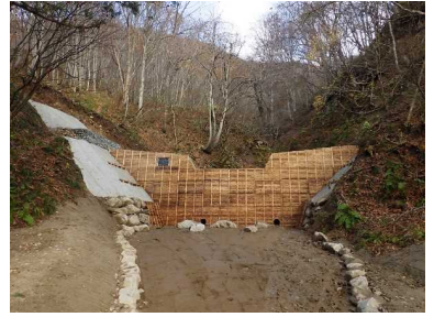
【治山：渓間工（治山ダム）】
