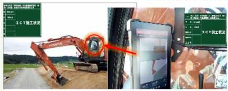
築堤工事で「ICT施工」を実施、工期短縮等により生産性向上
