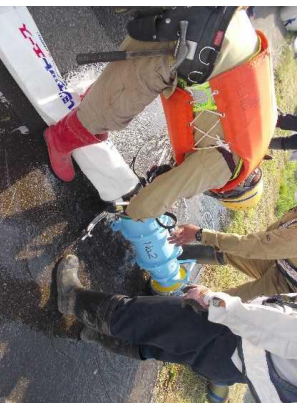
▲排水作業の準備状況
