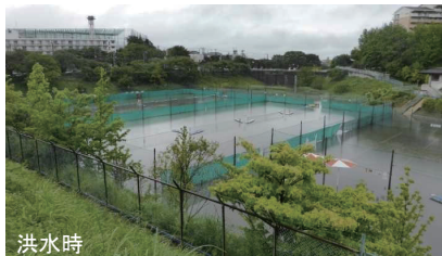
【事例：霧が丘調整池(横浜市)】
