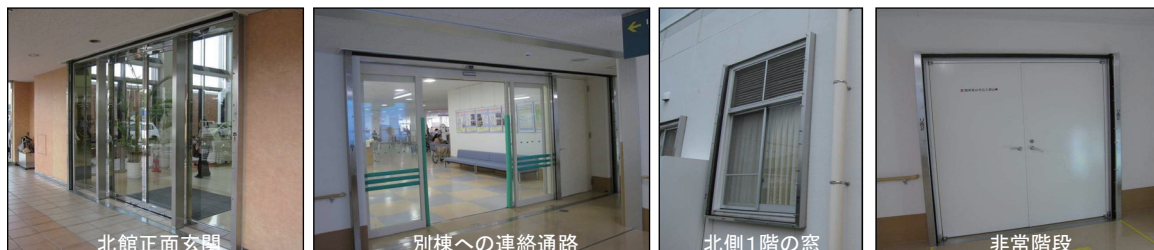
止水板のための角落としの設置
