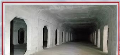
雨水調整池内部の状況(平成30年10月時点)
