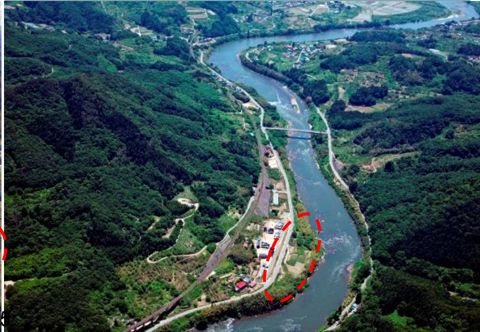
【伊達市内の事例(梁川地区)】
