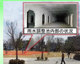
下水道事業による雨水貯留施設の例(郡山市)
