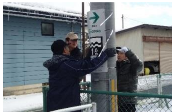
電柱などに浸水の深さ、避難ルートの案内看板を設置
