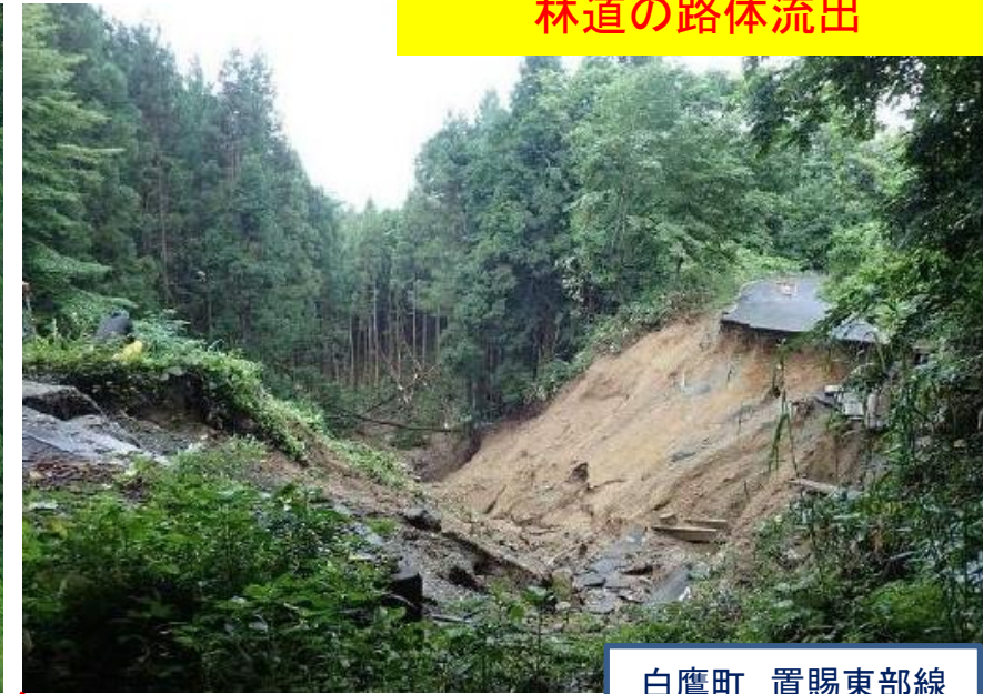
林道の擁壁倒壊
