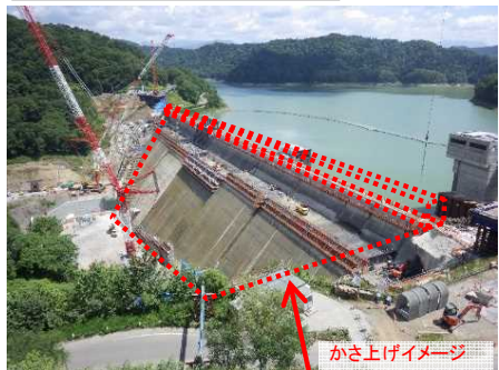
ダム建設・ダム再生
