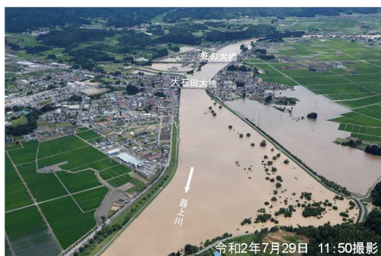
R2.7月洪水 (大石田町大石田・横山地区)
