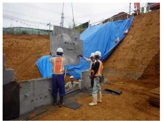
▲擁壁工施工状況例
