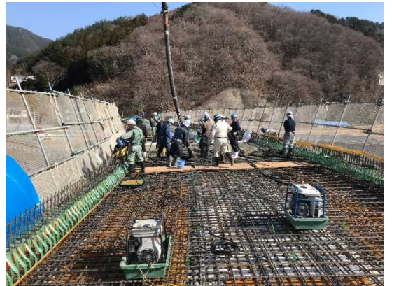
▲橋梁床版工施工状況例
