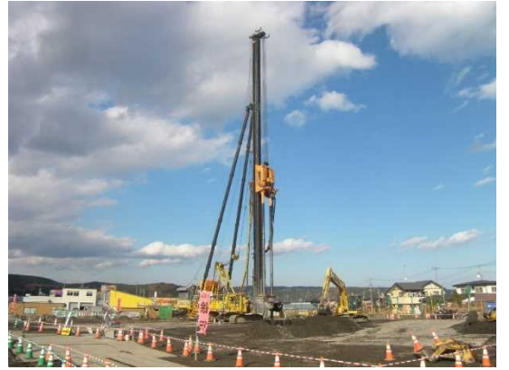
▲地盤改良施工状況例
