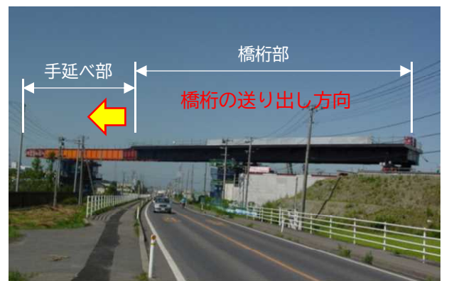
▲送り出し架設施工状況例
