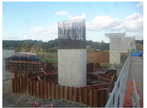
▲橋梁下部工施工状況例
