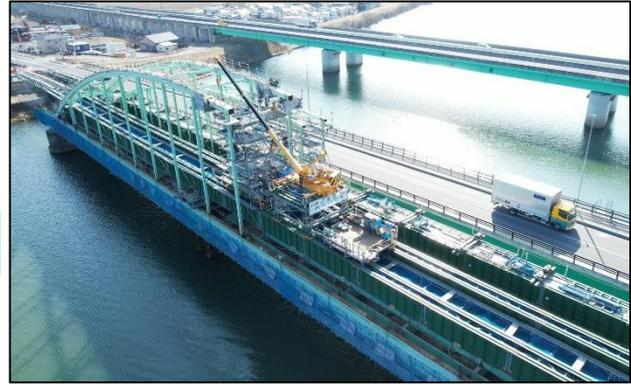
▲ドローンによる旧天王橋の撤去作業状況
