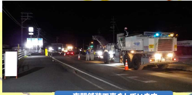
夜間舗装工事をしています
