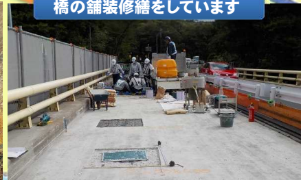
橋の舗装修繕をしています
