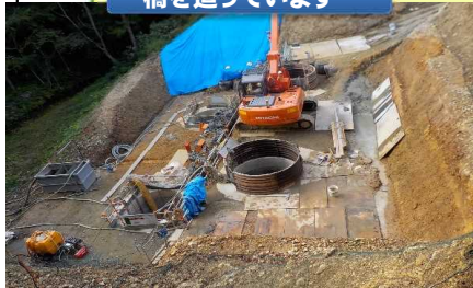
橋を造っています
