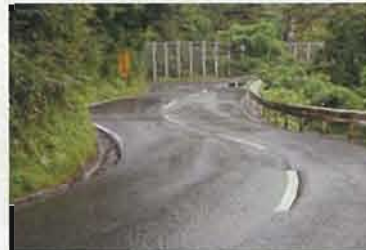
▲現道における線形不良箇所
