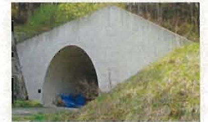
5号トンネル(起点側坑口)
