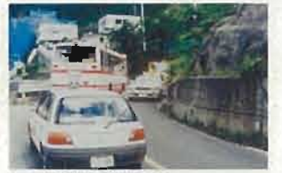
▲現道状況(線形不良)
