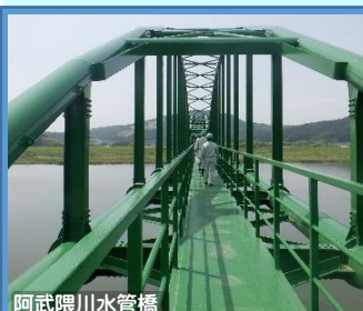
阿武隈川水管橋
