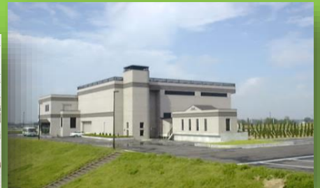
押分排水機場 (ポンプ場)
