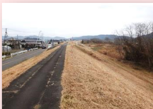
下流工区着工前
