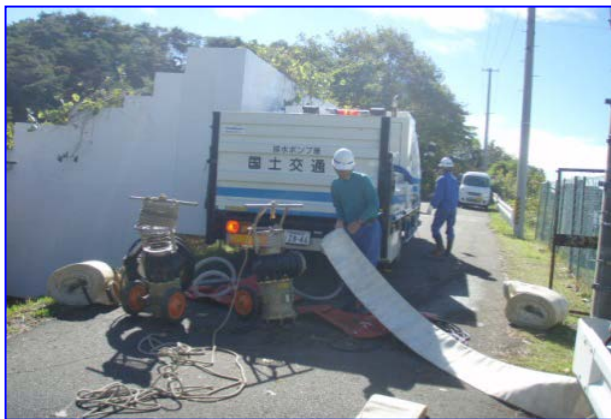
▲排水ポンプ車による排水作業(当時写真)
