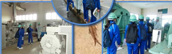
予備発電設備の説明
