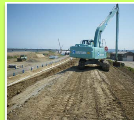
阿武隈川下流荒浜9工区 堤防災害復旧工事(盛土)
