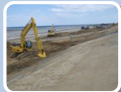
堤防の安全性についても点検し、必要に応じて堤防の質を改善し、強化する工事を実施しています。
