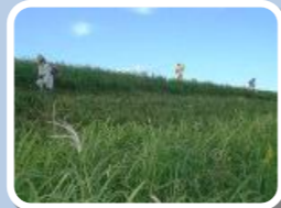
堤防に異常が無いかを確認するためにも、定期的に除草を行っています。
