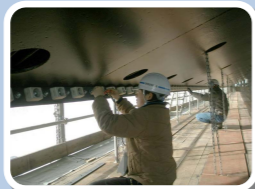
阿武隈大堰の施設を点検し、計画的に補修しています。
