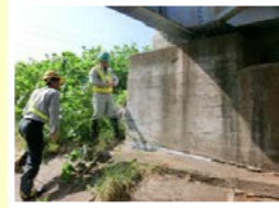
出水時の備えを万全にするため、管内の工作物(橋梁・樋管等)を関係者と合同で点検しています。
