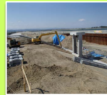
阿武隈川下流荒浜排水樋門 堤防災害復旧工事(路肩盛土)
