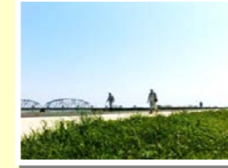
洪水時に備え、堤防に変状がないか歩いて細かく確認します。
