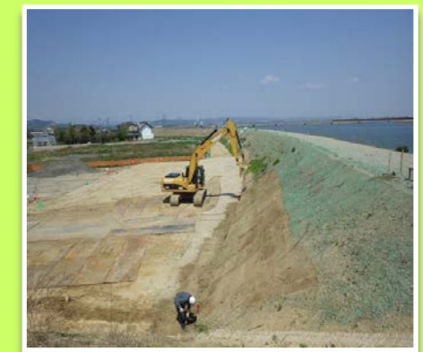
阿武隈川下流荒浜5工区 堤防災害復旧工事(盛土)
