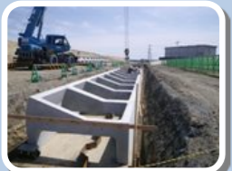
津波等で被災した堤防を強化し、津波や地震により強い堤防にする復旧工事を行っています。
