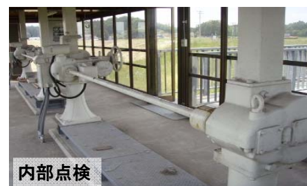
ゲートの動作確認
