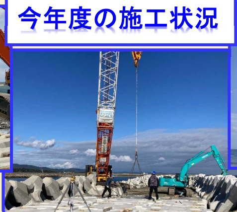
▲天端被覆ブロック据付の様子
