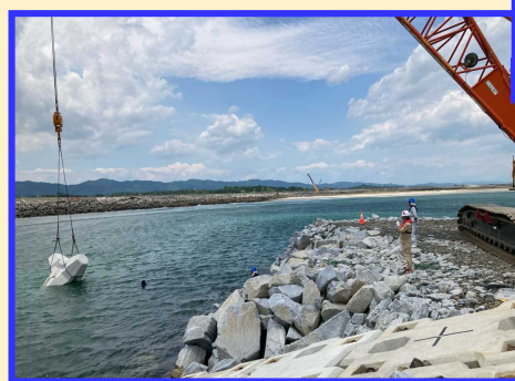
▲消波ブロック据付の様子
