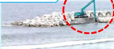
このバックホウで、捨て石を投入してヘッドランドを造成しているんだよ！
