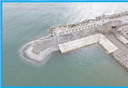
ヘッドランドは海上に石を投入して沖合に伸ばして土台を作る人工の岬です！
