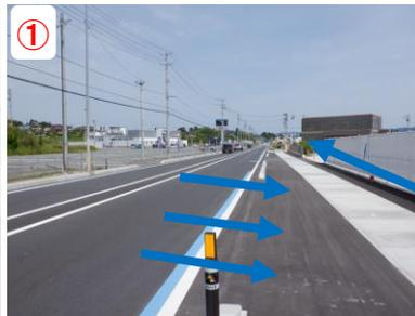
路面の水が側溝へ流れしていく。
