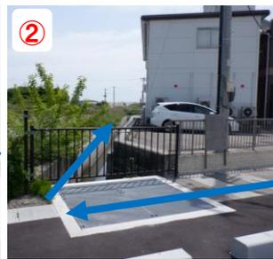
水が側溝を通り、水路へ流れしていく。
