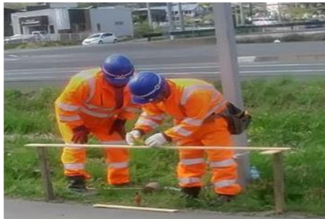
①測量をもとに、杭を入れる位置を確認
