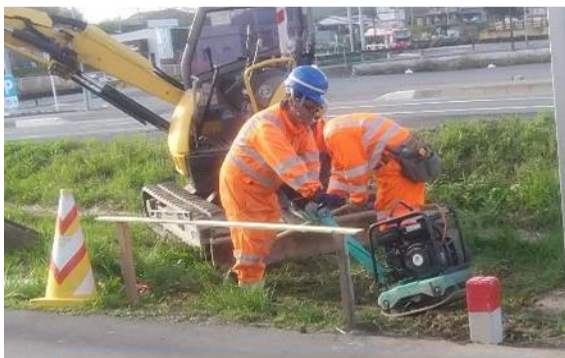
⑤機械で穴を掘ったところを整地
