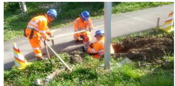
④杭を穴に入れ、測量して位置を確認して埋める
