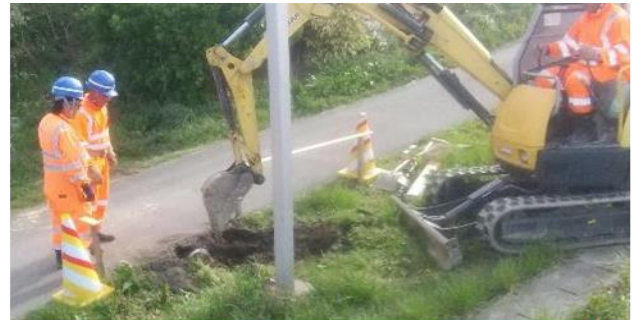
②機械で穴を掘る(深さ1m以上！)
