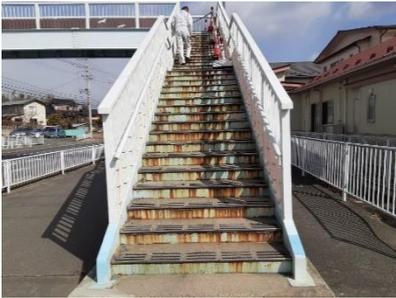
階上横断歩道橋の階段部分が腐食・欠損
