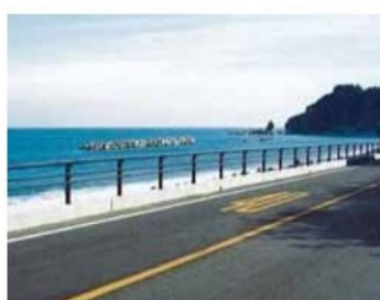
■防護柵更新後の状況
