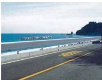
■防護柵更新前の状況
