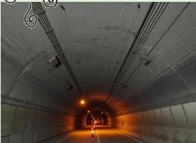
灯具の老朽化によりトンネル内が暗く危険！
