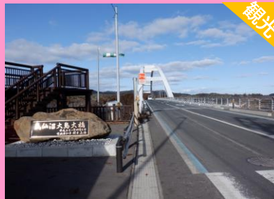
①気仙沼大島大橋(鶴亀大橋)
