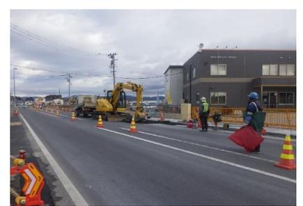
※横断函渠（ボックス）を設置するために掘削を行っています！
