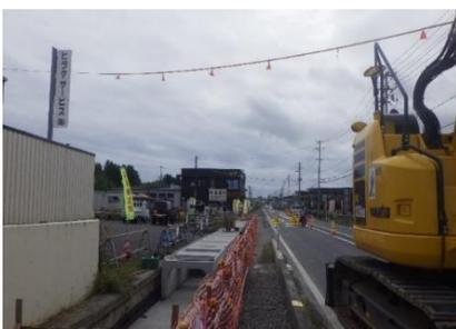
元々設置されていた側溝は新しい側溝に入れ替えるため撤去しました。
