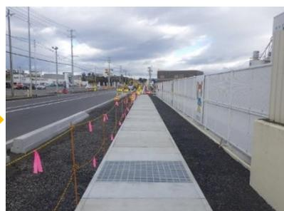
水の流れを良くするために大きな側溝を設置しました！
