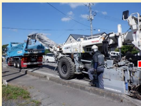
機械で舗装を削り取っている様子です。
