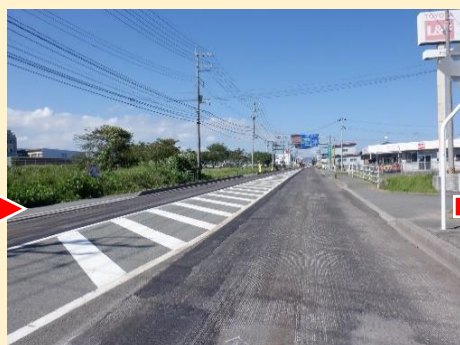
舗装を剥がして、道路の傷み具合を確認しています。
