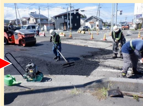
新しい舗装を敷設しています。
