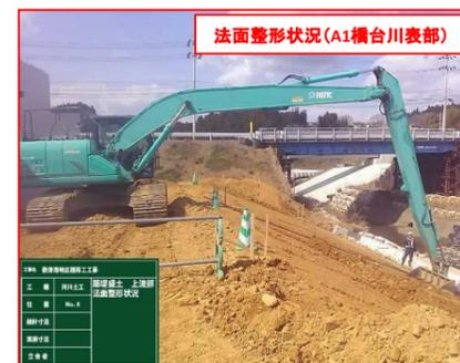
盛土を締め付けた後、斜面となる部分をバックホウのロングアームを使用し整形を行っています。
