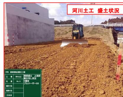
堤防の主となる盛土材料を、ブルドーザで30cm毎層状に敷均し・転圧を行っています。(A1橋台川表部)
