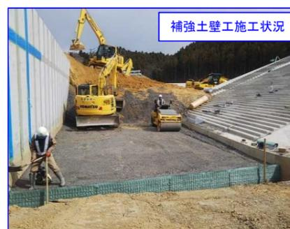
橋台(国道45号線)の背面に補強土壁工の施工を進めています。
