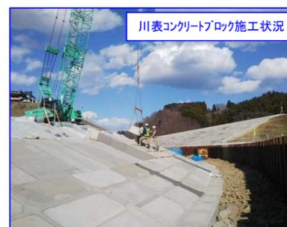
堤防法面の下部へコンクリートブロックの設置を行いました。(川表側)
