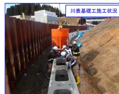
護岸の基礎となる基礎ブロックの施工が完了しました。(川表側)
