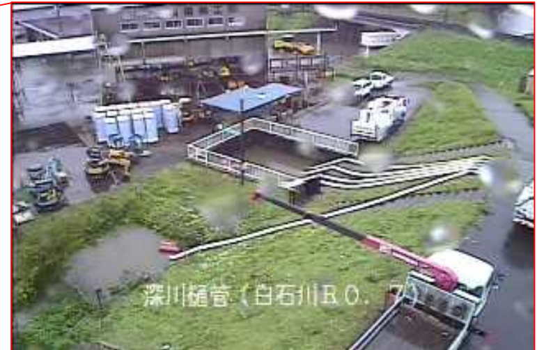
▲排水ポンプ車設置状況
