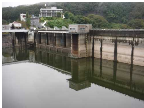
10月11日15:00時点の貯水位状況
