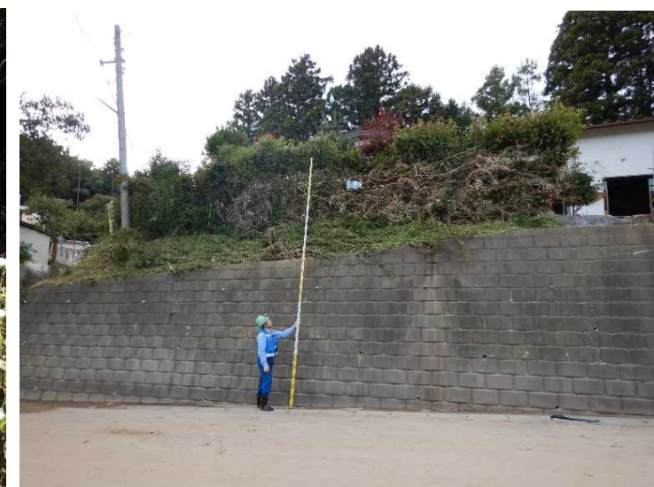
丸森町被災状況調査（10月17日撮影）
