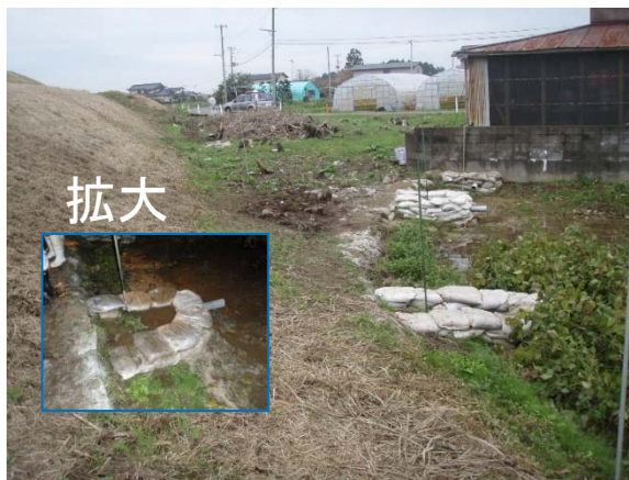
【月の輪工法 3箇所設置】
