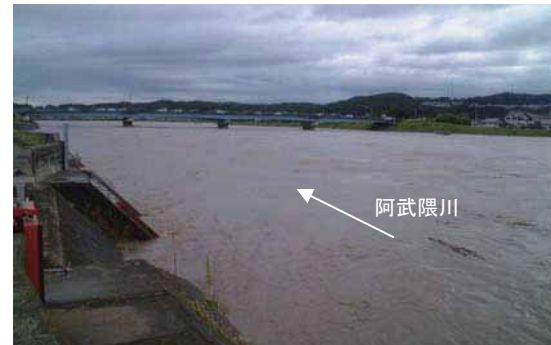
昭代橋付近の状況（福島県本宮市）
