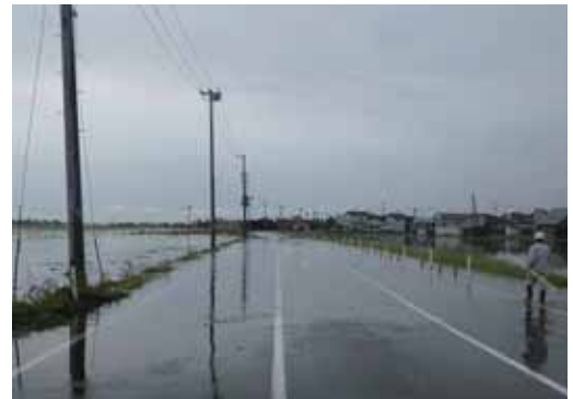
台風 15 号 (平成 23 年 9 月) による一般県道岩沼海浜緑地線の浸水状況
