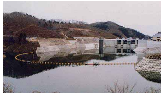
三春ダム 流木止施設
