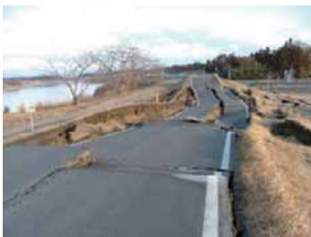
阿武隈川右岸 22.0k 付近 (角田市坂津田地先)
