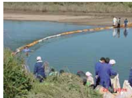
平成 13 年 9 月 23 日 重油の流出事故発生時に設置した オイルフェンス (福島県須賀川市)
