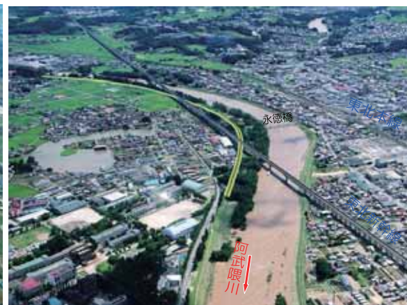
御代田地区(無堤箇所) 河口より140.6～142.4km右岸
