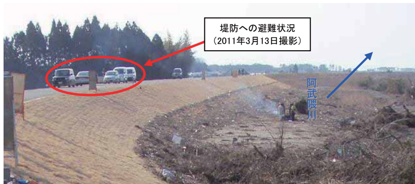
寺島堤防(岩沼市寺島地区)
