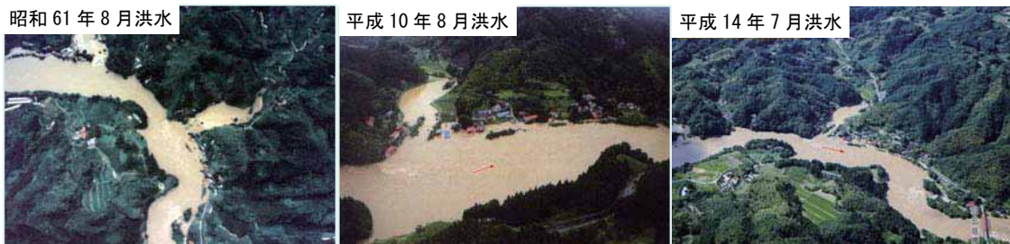
宮城・福島県境狭窄部における浸水被害状況 河口より47.0k付近(宮城県丸森町)
