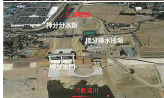
写真上：昭和 61 年 8 月 五間堀川付近浸水状況 写真下：分水路・水門・排水機場の整備 【出典：仙台海川国道事務所資料】
