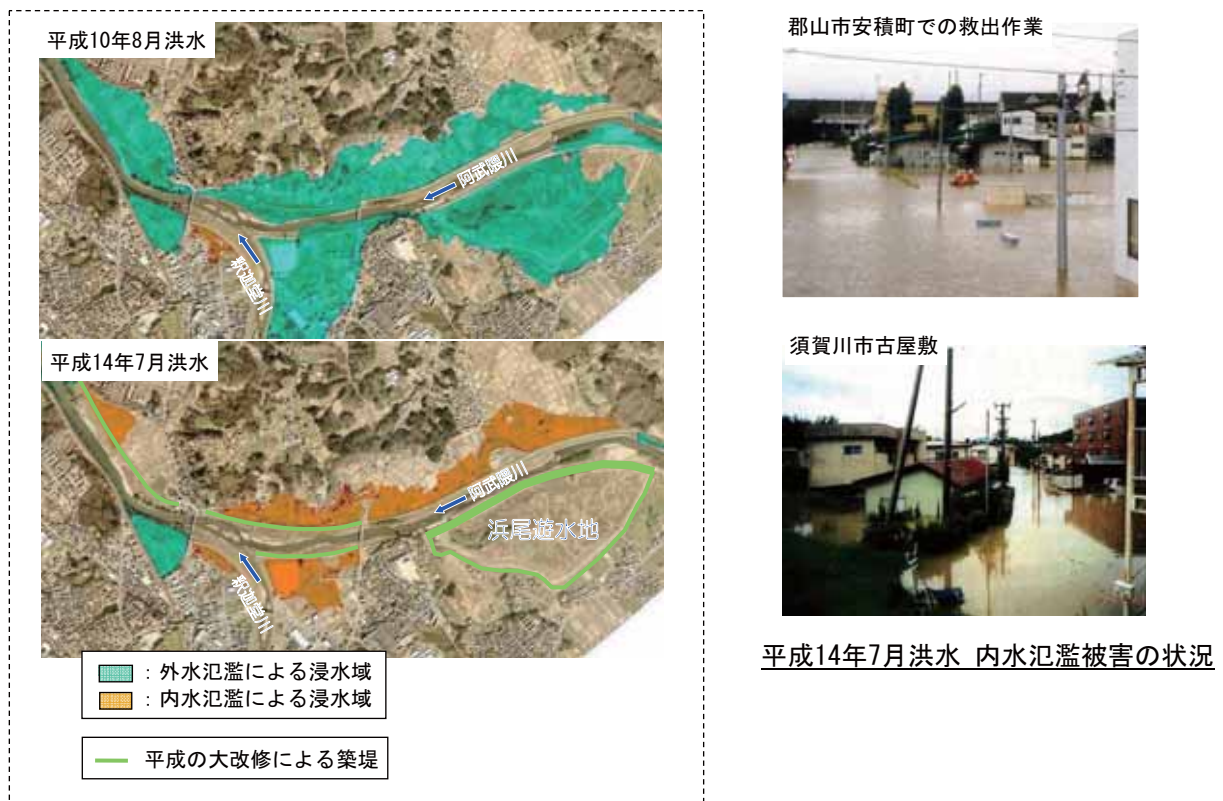
図 3-8 内水被害の顕在化の例【須賀川市】
