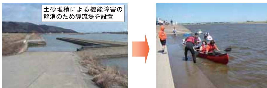
既設施設のフォローアップの例 ～機能障害を解消するために設置した導流堤～
