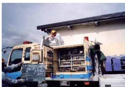
排水ポンプ車点検の様子
