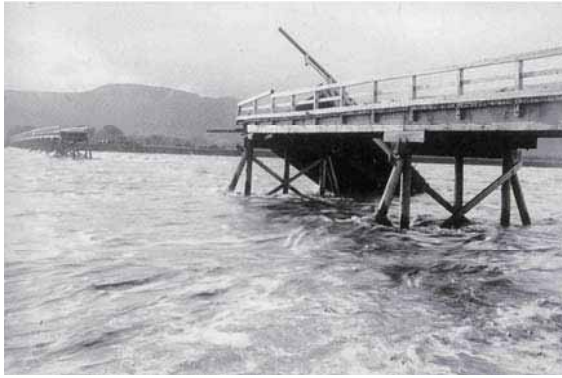
伊達崎橋の流失（福島県伊達市）
