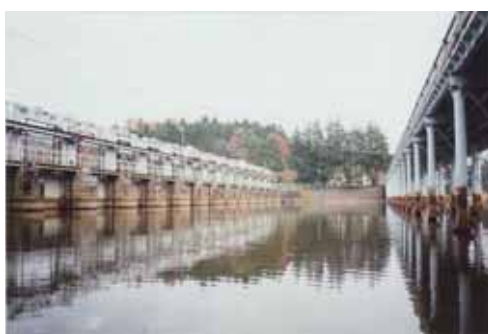
猪苗代湖面水位調節施設 十六橋水門(明治13年)
