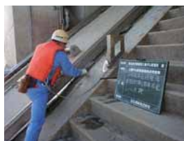
係船レールの点検状況
