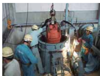
排水機場点検の様子
