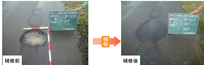
堤防天端舗装の補修
