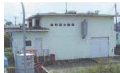
南町排水機場(福島市)
