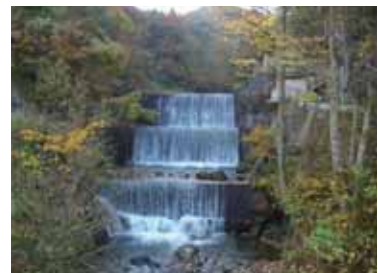
東鴉川第一砂防堰堤
