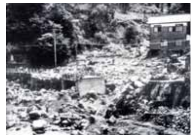
荒川右支川東鴉川の土石流被害
