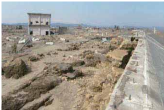
津波によって崩壊した堤防 (阿武隈川右岸-0.1k付近 (巨理町荒浜地先))
