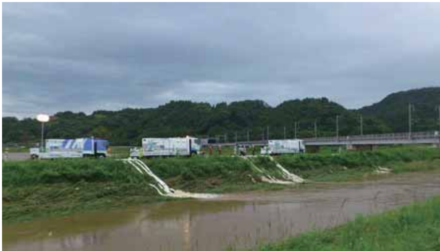
排水ポンプ車の活動状況
