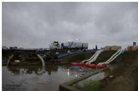
排水ポンプ車による 緊急排水の活動状況
