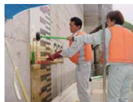
量水板の清掃状況
