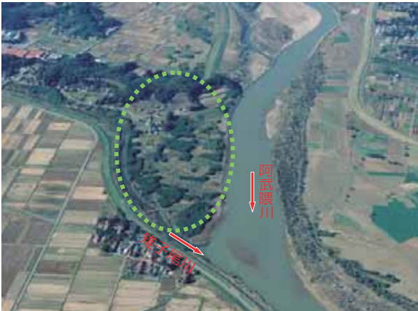
金山地区(無堤箇所) 河口より 33.7～ 34.4km 右岸
