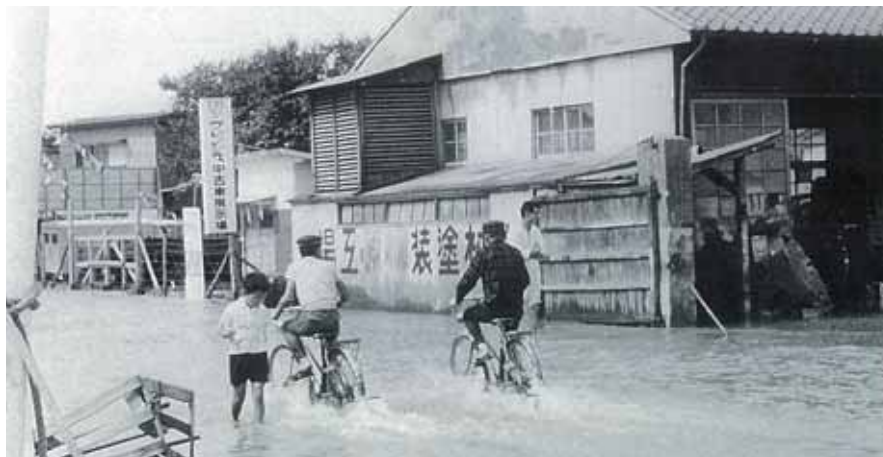
国道 115 号の冠水状況（福島県福島市）
