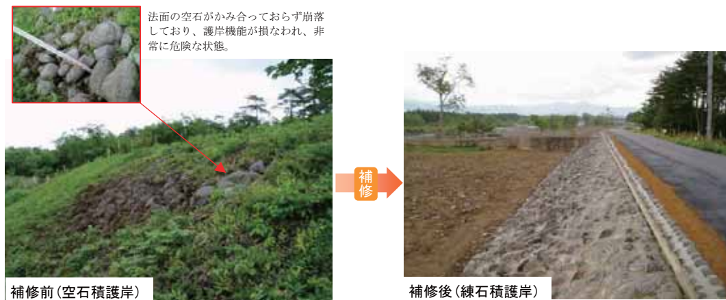
空石積護岸の補修(支川荒川)
