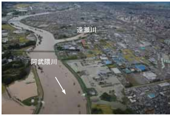
市街地の浸水状況（福島県郡山市）
