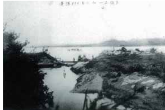
角田市平貫の堤防決壊
