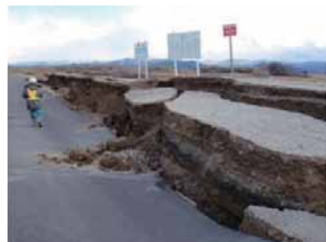
阿武隈川右岸 31.0k 付近 (角田市枝野地先)
