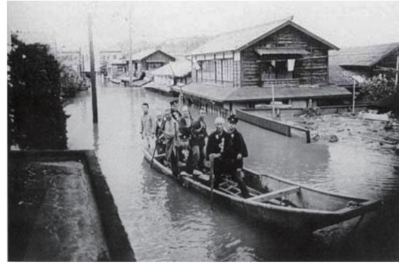
旧本宮町役場の冠水状況
