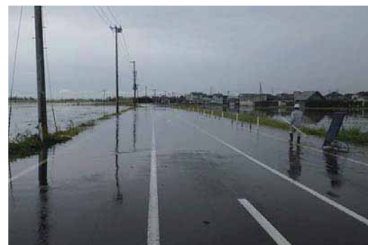
平成23年9月浸水状況 一般県道岩沼海浜緑地線
