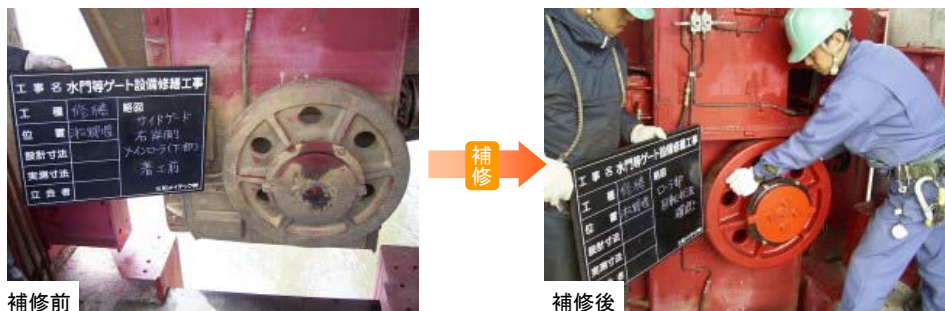
写真7-1 ゲート設備の維持補修
