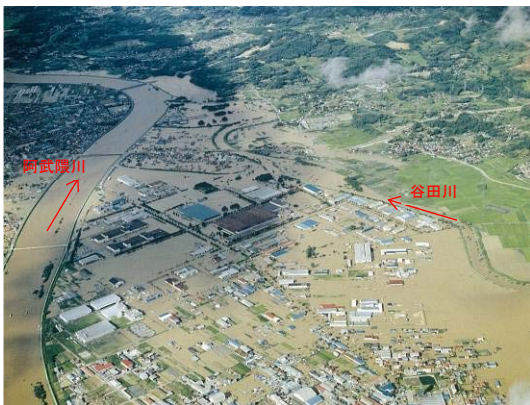
写真1-1 昭和61年8月洪水の浸水状況 郡山市谷田川合流点付近
