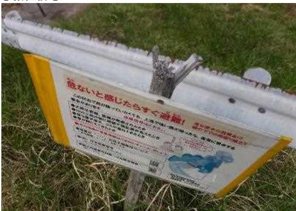
看板の老朽化(支柱木製部の劣化)
