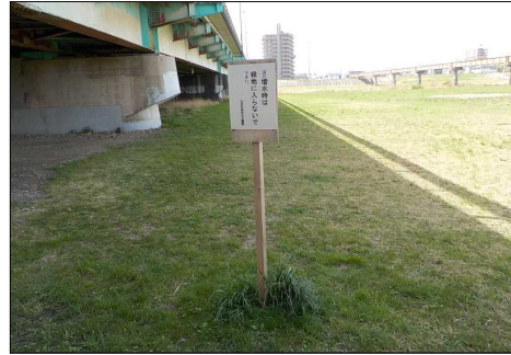
打ち込みにより固定
