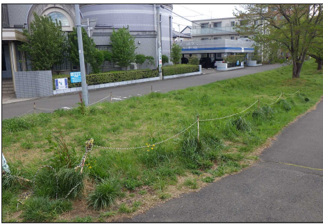
立ち入り禁止ロープの緩み及び劣化
