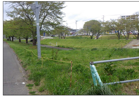
ロープ交換のうえ張り替え
