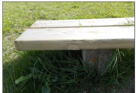
座面劣化箇所のパテ埋め
