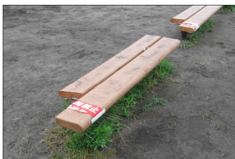
破損部の注意喚起措置
