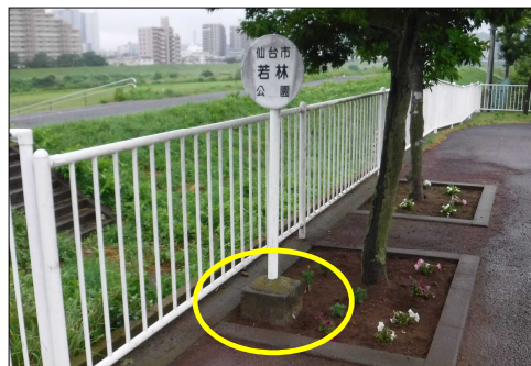
看板基礎の埋設
