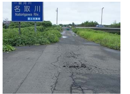
天端舗装の補修
