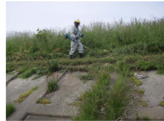
肩掛け式除草機械による除草状況
