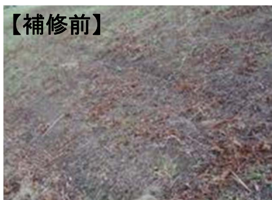
堤防法面の損傷状況（裸地化）
