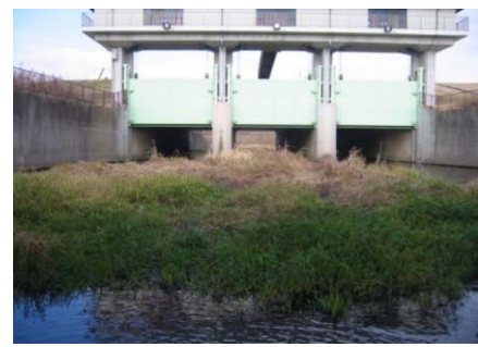
堆積土砂の撤去
