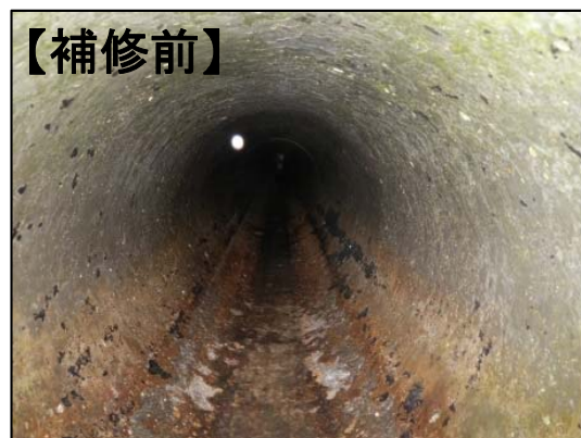
樋管損傷状況（管体内の欠損）
