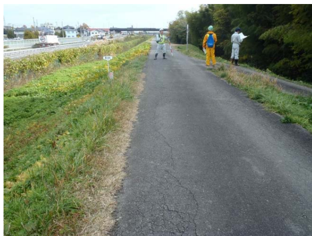
堤防点検の実施状況
