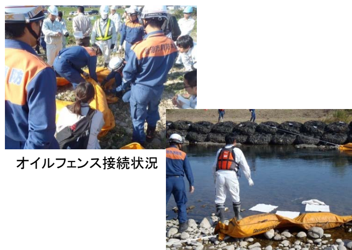
オイルフェンス設置、油吸着マット投入
