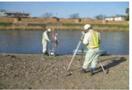
定期縦横断測量
