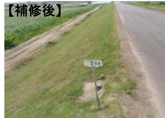
法面補修状況
