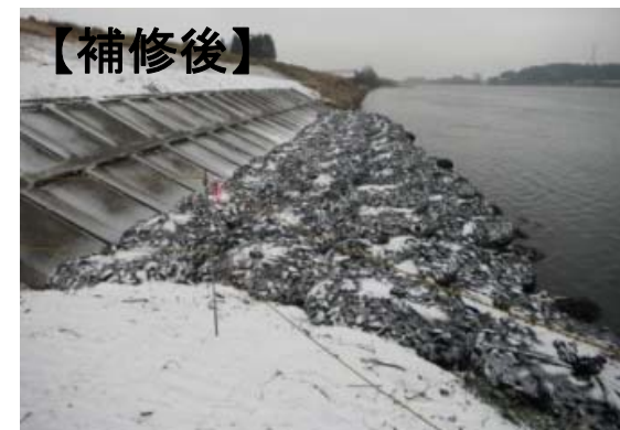
護岸補修状況（袋詰根固め）
