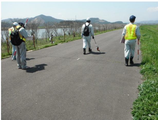
堤防点検の実施状況
