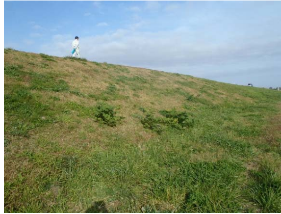
堤防の表面が見え、堤防の異常の有無が確認できる状態
