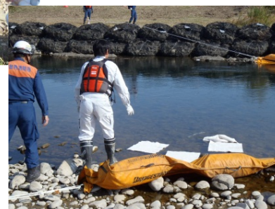
オイルフェンス設置、油吸着マット投入
