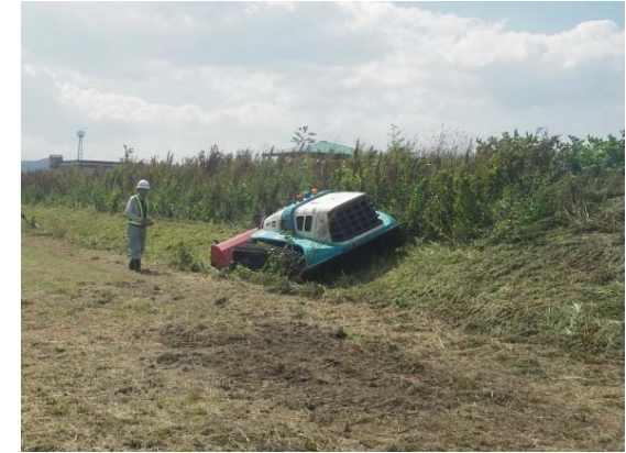
大型遠隔式除草機械による除草状況
