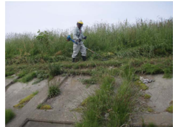
肩掛け式除草機械による除草状況
