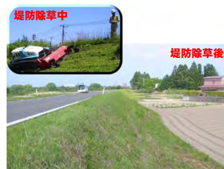
堤防の除草状況
