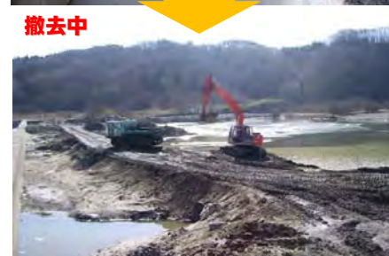
土砂撤去の状況(貯砂ダム)
