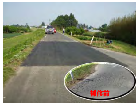
広瀬川堤防天端舗装状況
