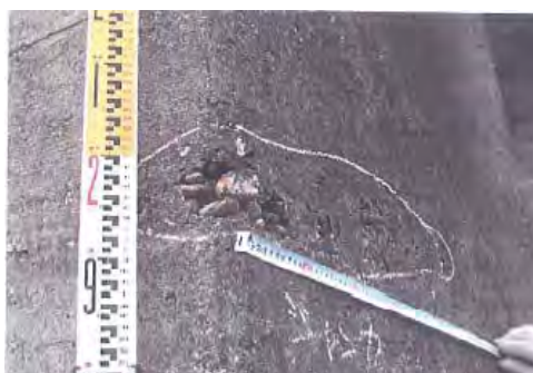
門柱の破損
