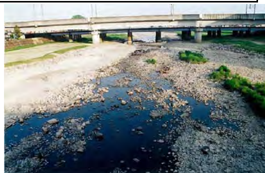
平成 6 年渇水時写真(広瀬川)
