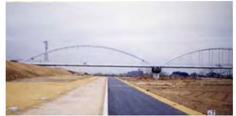
緊急河川敷道路
