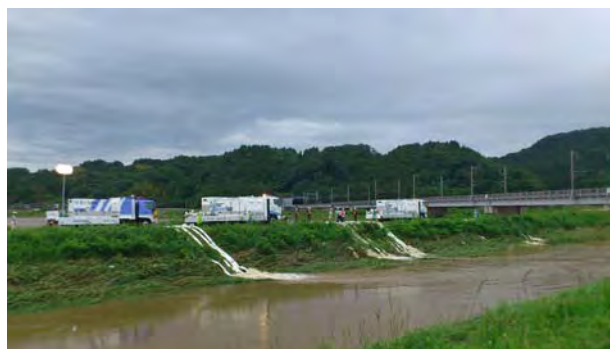
排水ポンプ車の活動状況
