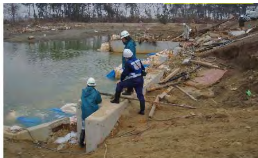
TEC-FORCE の派遣状況 (H23.4.11 井土浦川付近)
