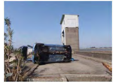
被災状況 (河口から右岸 0.0k 付近、 名取市関上地先)
