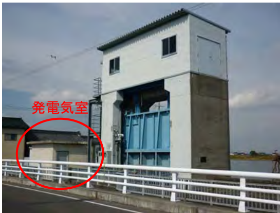
閉上水門(地震前)
