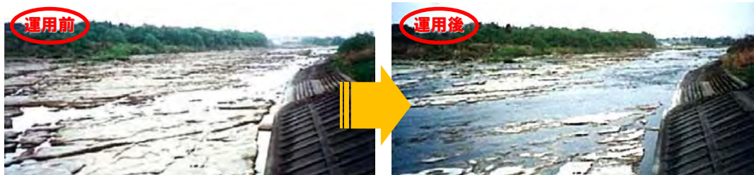
弾力的管理試行状況(名取川頭首工下流の状況)
