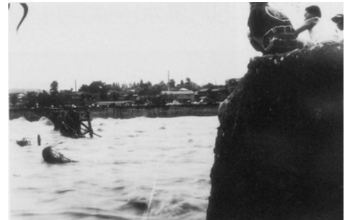
評定河原橋の流出
