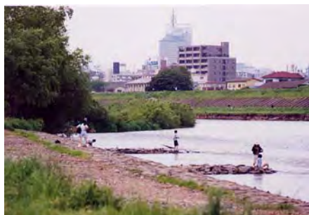
環境及び親水性に配慮した水制工
