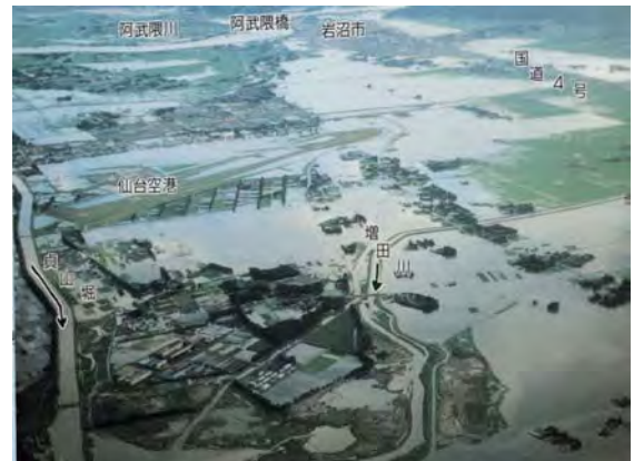
仙台空港周辺の浸水状況
