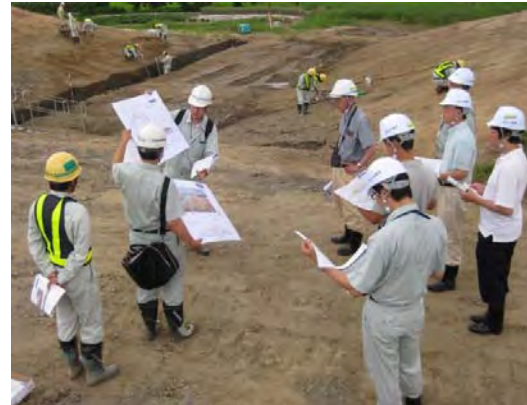
堤防被災の原因調査状況
