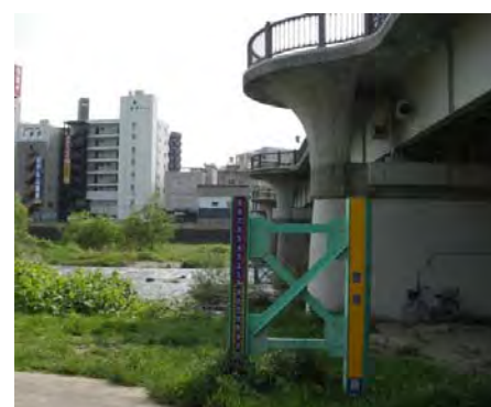
危険水位表示板（広瀬橋）
