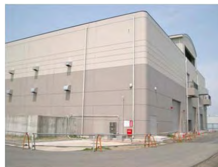
長町第一ポンプ場 (仙台市下水道)
