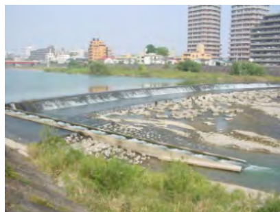
郡山堰（広瀬川 4k 地点）
