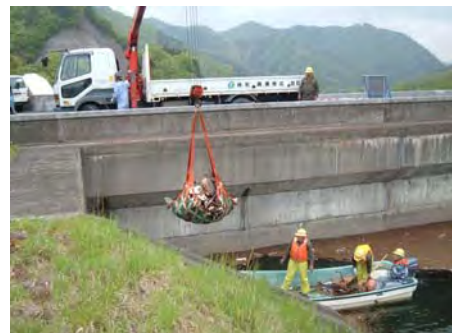
釜房ダム 流木処理
