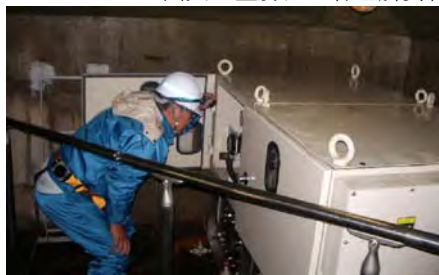
放流設備の点検
