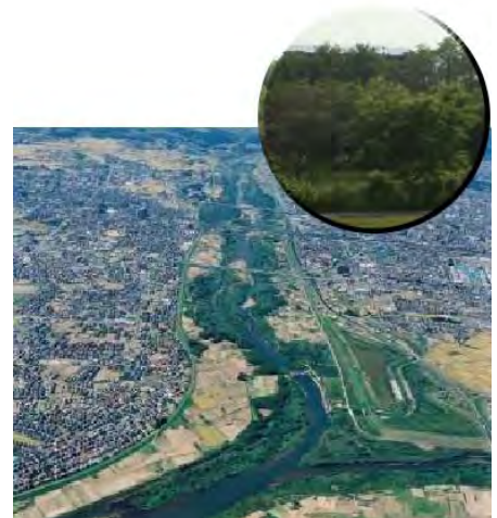
河道内樹木の状況
