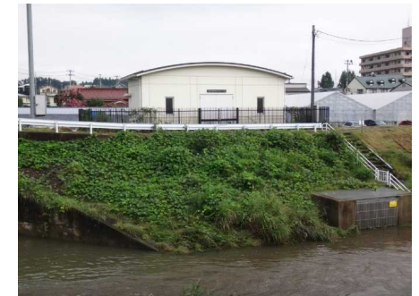
導水施設(取水ポンプ場)
