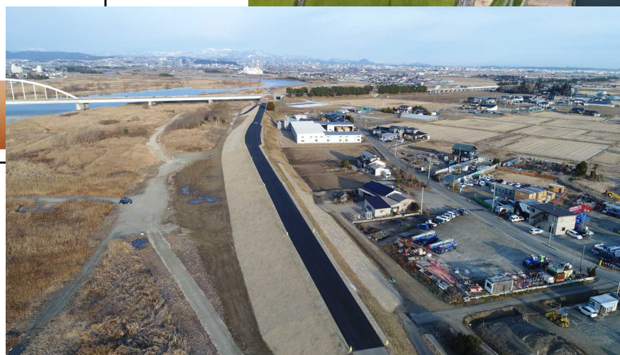
日辺地区堤防整備状況
