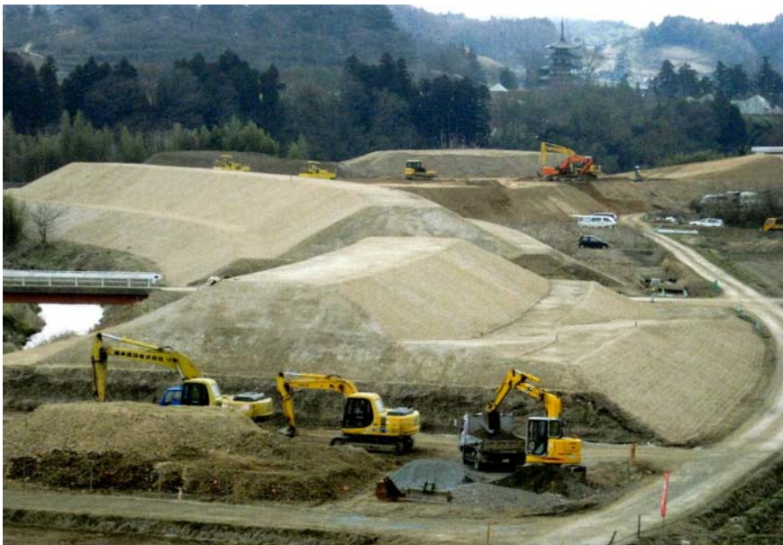
写真は「阿武隈川左岸油井地区築堤工事」の事例(イメージ)
