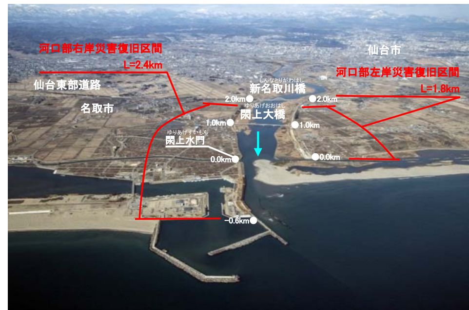
復旧状況斜め写真(平成26年1月7撮影)
