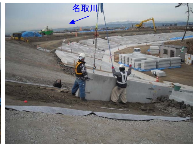
被覆ブロック設置状況(地点②付近)
