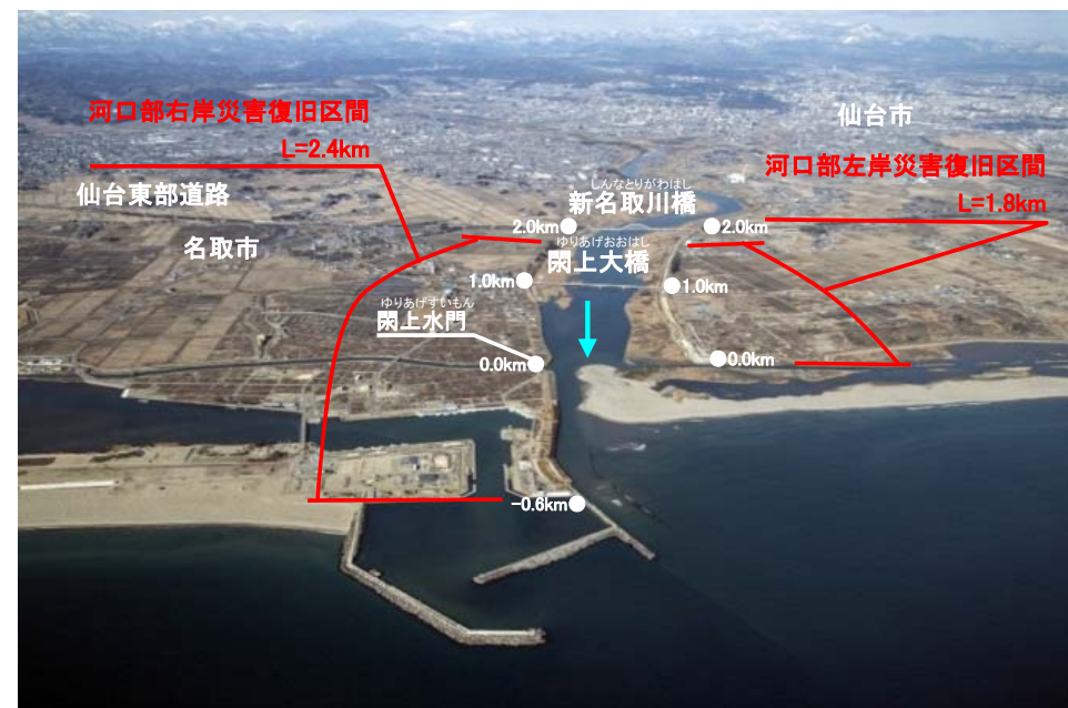
復旧状況斜め写真(平成26年1月7撮影)
