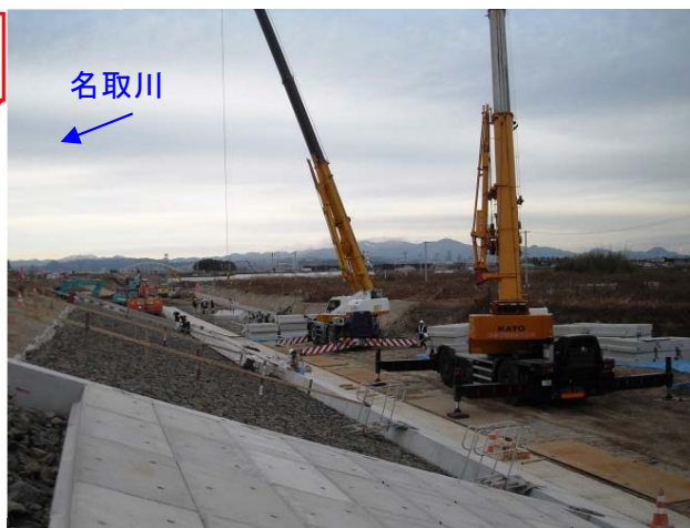
被覆ブロック設置状況(地点①付近)
