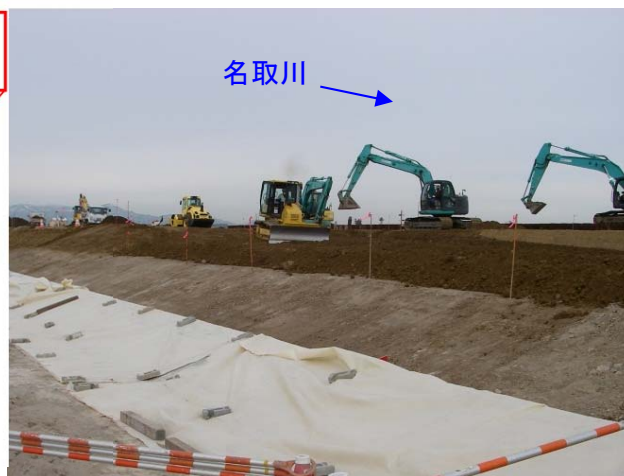
堤防盛土施工状況(地点①付近)
