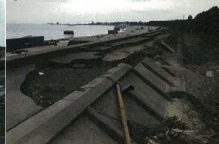
⑤七ヶ浜海岸 菖蒲田地区 (堤防天端裏法被災) ⑥岩沼海岸 相ノ釜・納屋地区 (堤防決壊)
